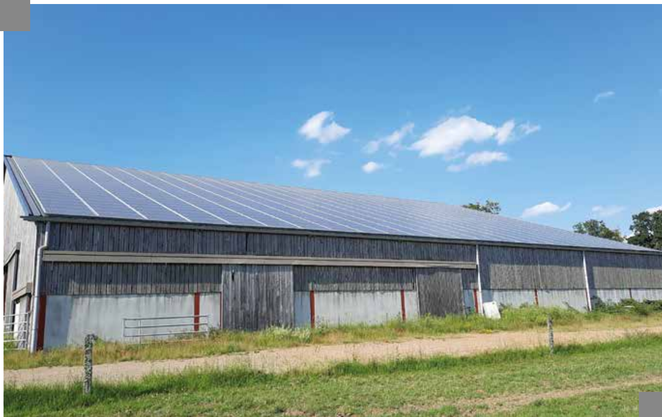
Un des bâtiments détenu par la SAS.
